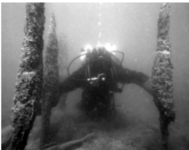
Ein Taucher bei einem Erkundungstauchgang zwischen erodierten Pfählen, die bis 1.5 m aus dem Seegrund ragen. Für den Erhaltungszustand ist dies ein schlechtes Zeichen, das auf massive Erosion hinweist.
